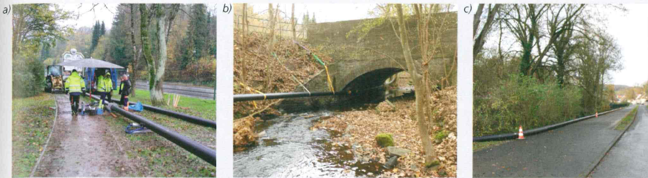
Bild 2: a) Verschweißen der Abwasserüberleitung, b) Brückenquerung, c) Abwasserüberleitung
