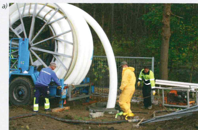
Bild 4: Einzug eines Compact Pipe-Rohres in den Altkanal
