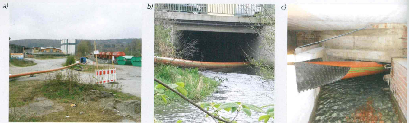
Bild 7: a) Schweißplatz an der Bahnlinie, b) Einzug durch die Wäster in den Entlastungskanal des Regenüberlaufs, c) Querung Regenwasserbauwerk
