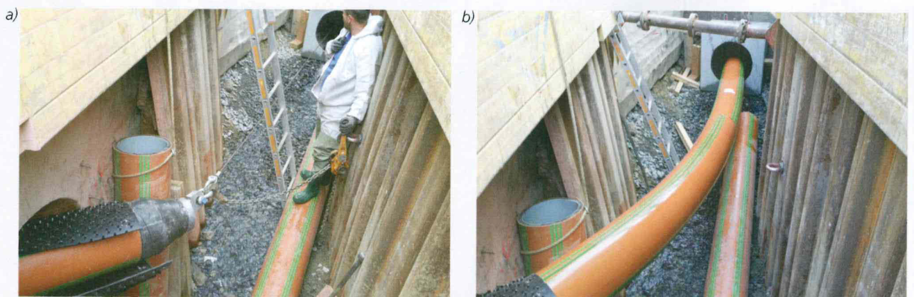
Bild 8: a) Einzug durch eine mittels Kernbohrung hergestellte Verbindung zwischen Schachtbauwerk und Startgrube. Im Hintergrund ist der Beginn der eigentlichen Einzugsstrecke zu sehen, b) Startgrube für den Einzug mit einer Gesamtlänge von 620 m entlang der B55
